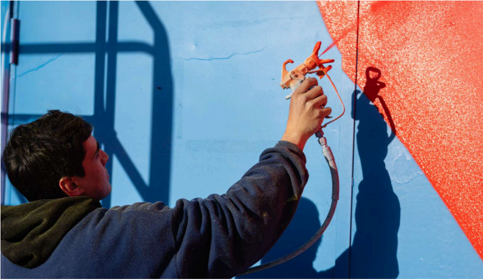
Pistolet à peinture : permet une application uniforme de la matière
